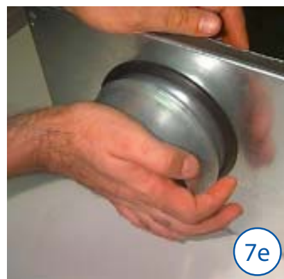
7e - Tegye be a csatlakozó idomot a csónkba. Szappanos vizet használjon, ha nem tudja benyomni.
