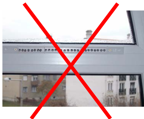
(3. ábra) Tipikus beépítés FA nyílászáróba
